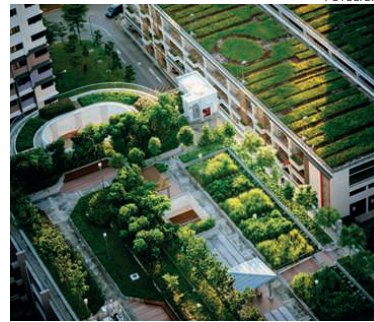
Exemplo de telhado/parede verde
